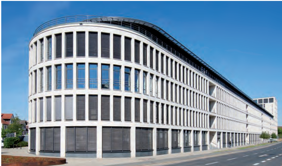
Standort der Allianz für die Region GmbH im Kontorhaus in Braunschweig
