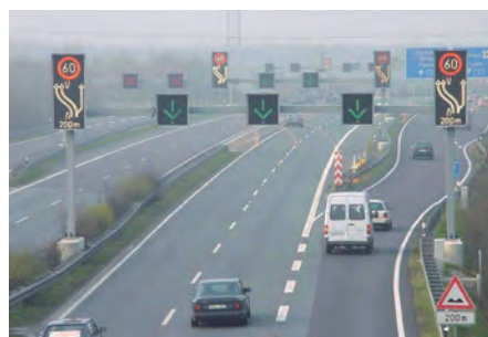
Telematik-Elemente am Messeschnellweg Hannover
