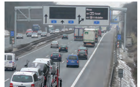
Dynamische Wegweiser auf der A2 (dWiSta)
