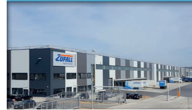
Bildnachweis: Goldbeck-Nordost GmbH
